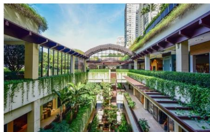
No Shopping Cidade Jardim, as obras estão permitidas das 22 horas das 10 horas enquanto o empreendimento estiver com o horário de funcionamento reduzido. (Foto: Marcio Correia)
